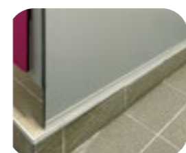
Fixation au sol dans profil U
